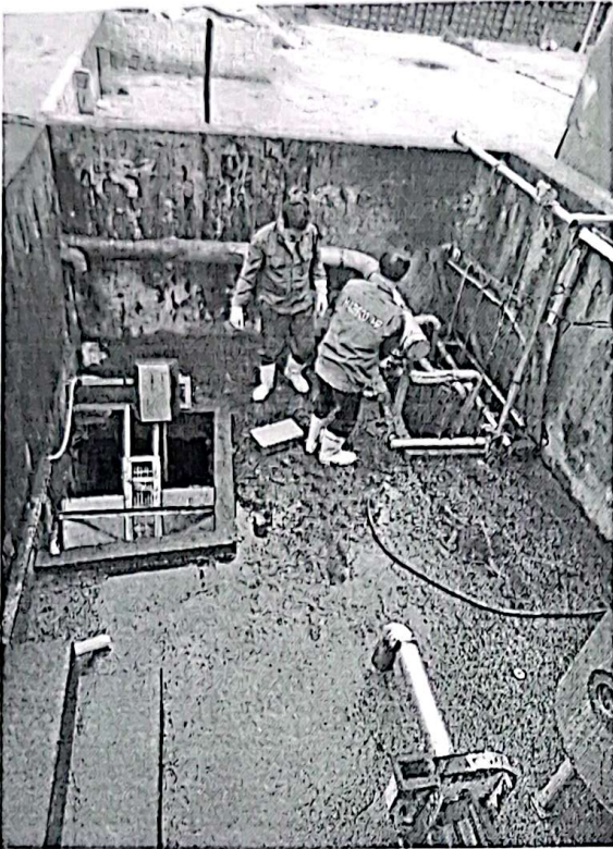
ảnh 3: sửa chữa bơm bể gom
